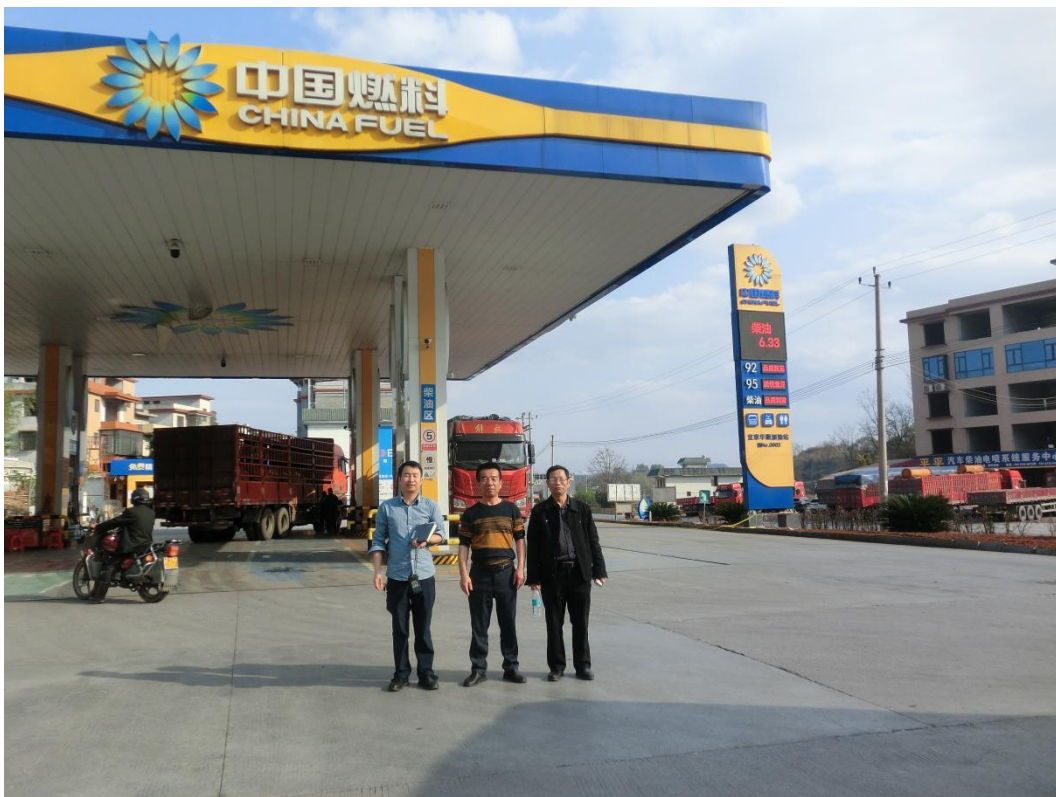
图 2：评价人员现场勘察照片
