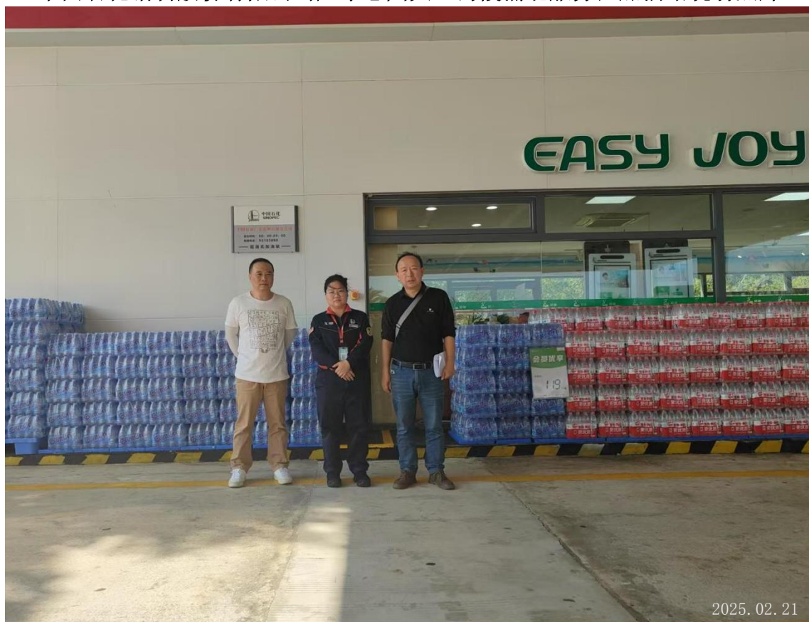
中国石化销售股份有限公司广东惠州大亚湾霞涌北服务区加油站现场照片
