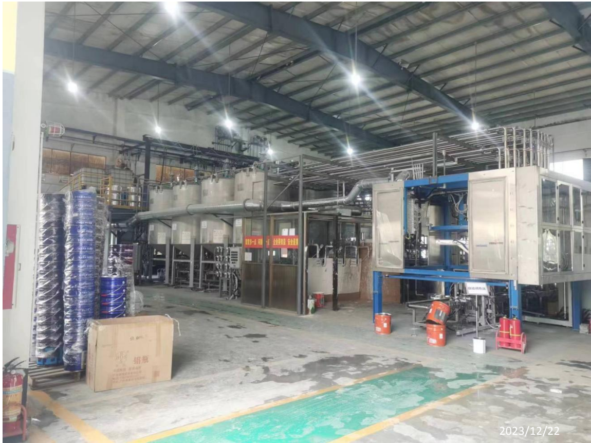
广东德丽雅新材料有限公司现场勘察影像：
