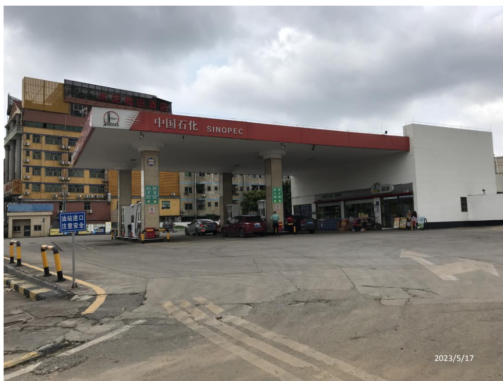
中国石化销售股份有限公司广东东莞桥头田头角加油站现场照片：
